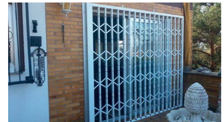
Breites Scherengitter über Balkontür-Element geschlossen
