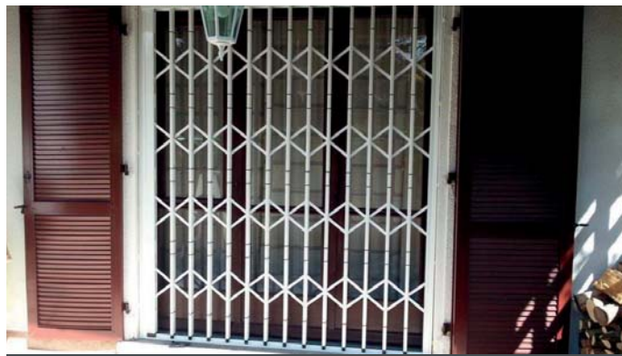
Flexa Base zwischen Fenster und Klappladen
