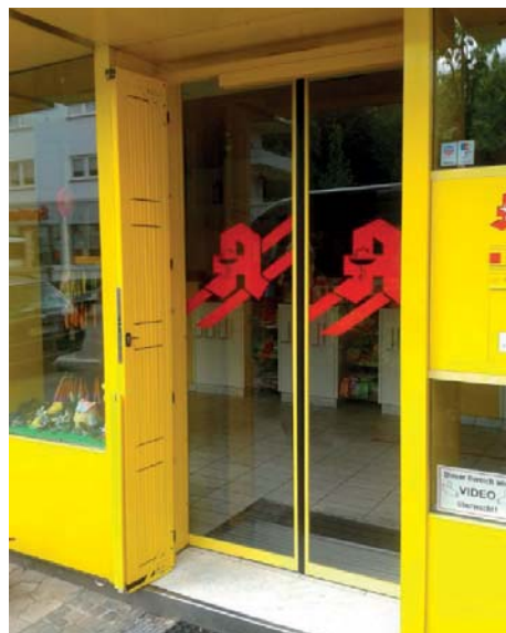
Flexa Pack seitlich weggeklappt wegen Durchgangsbreite
