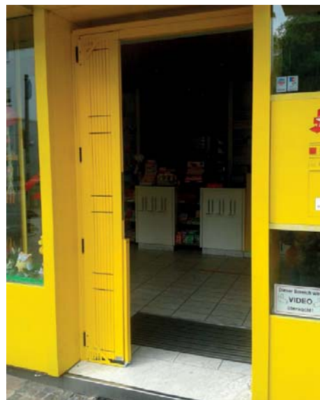
Flexa Schwelle hochgeklappt wegen Stolperstufe
